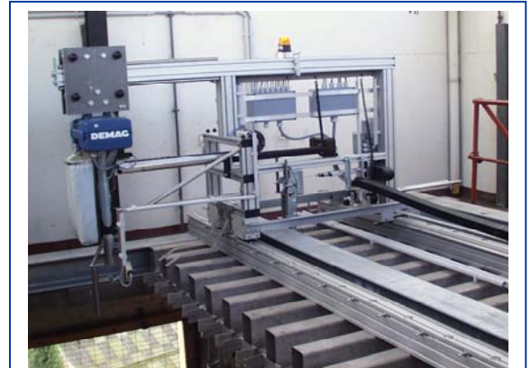
(Bahnenanlage SBA mit Demag Kettenzug und Aufhängebahnen aus Edelstahl)
